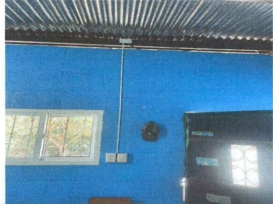
Foto 2: Mantenimiento del sistema eléctrico ya finalizado de todo el Establecimiento.
