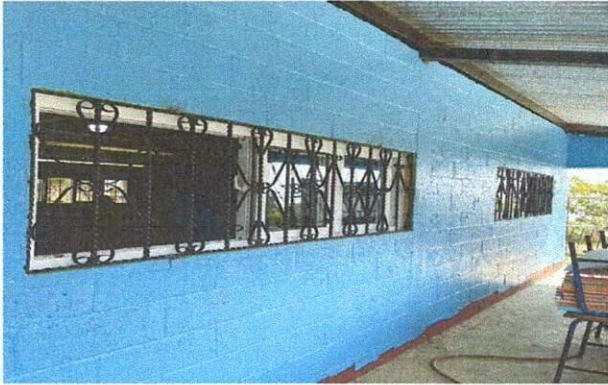
Foto 1: Mantenimiento de ventanas y balcones ya finalizado de todo el Establecimiento.
